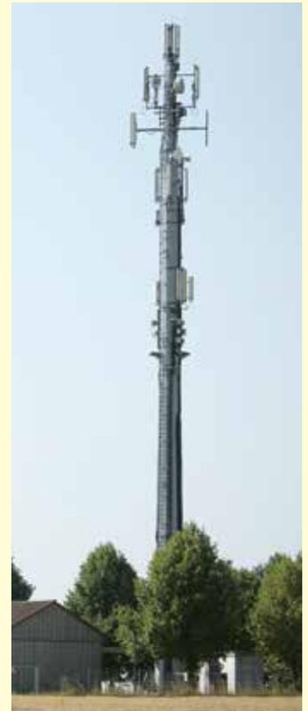
*Im Bereich Belm-Icker baut die Deutsche Telekom in diesem Jahr einen neuen Mobilfunkmast in Schleuderbetonbauweise. Der Mast soll noch in diesem Jahr in Betrieb genommen werden.*
