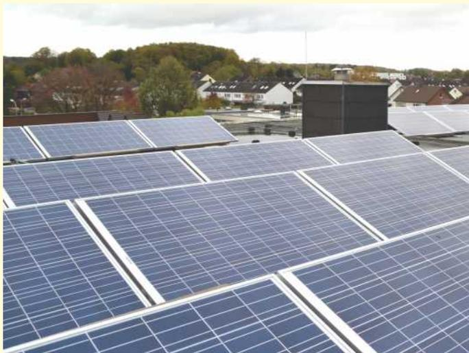
Bereits seit 2013 sind 27 Solarmodule auf dem Dach des Belmer Rathauses installiert und produzieren in Spitzenzeiten bis zu 6,89 Kilowatt Peak. Belmer Hausbesitzer, die auch über eine Photovoltaikanlage auf ihrem Hausdach nachdenken, können sich beim Themenabend des Belmer Klimabotschafters am 14.09. informieren.
